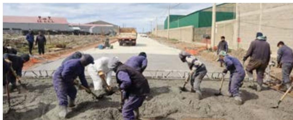
tiro completo del hormigón, incorporación de suelo, compactación y finalmente inició el hormigonado de la calzada, para luego pasar a su etapa de fraguado.
