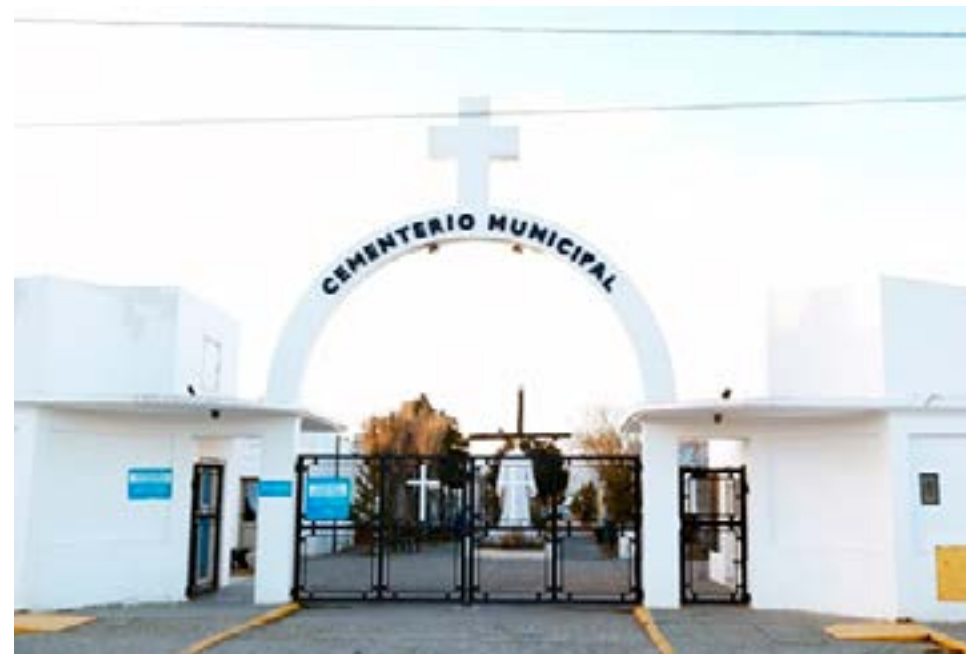
Robo en una obra dentro del Cementerio Municipal.
